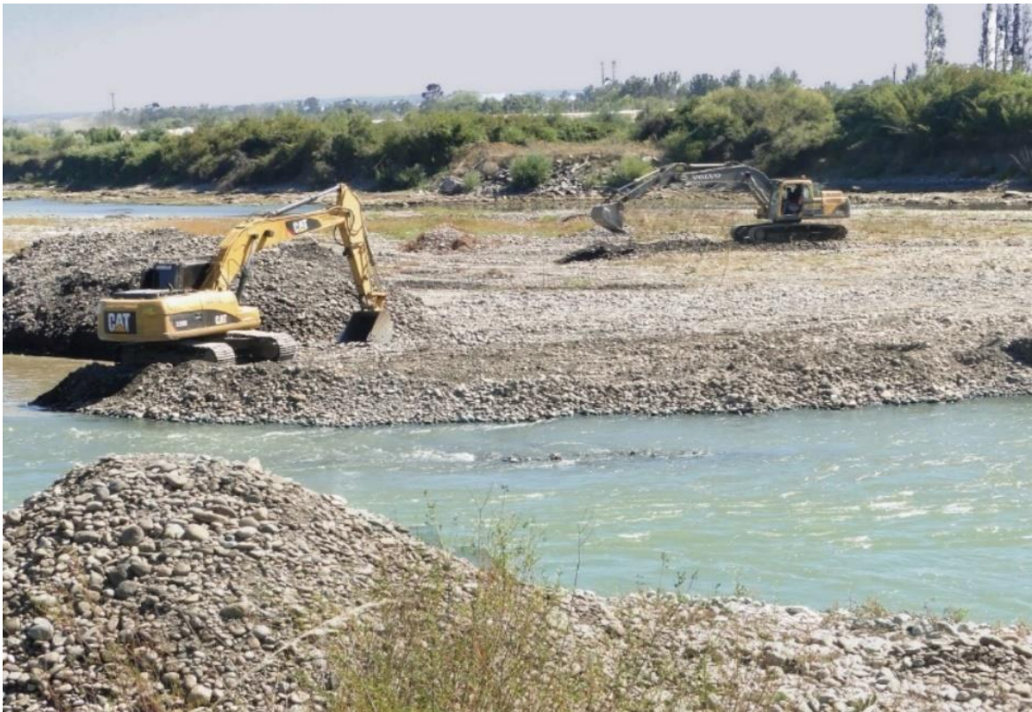
Figura 2.2. Fotografía extracción de áridos río cautín, Temuco.
