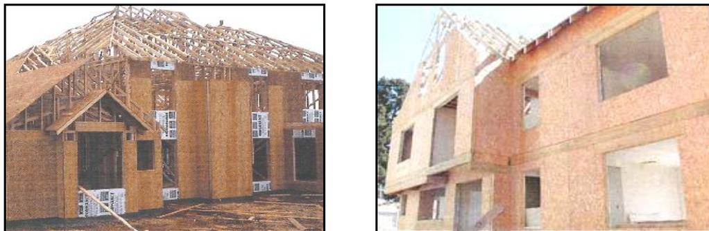
**Figura 6.** Tablero OSB en Muros.
