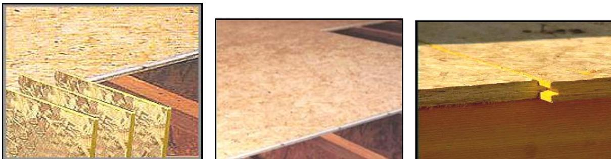
**Figura 7.** Tablero OSB en Pisos.
