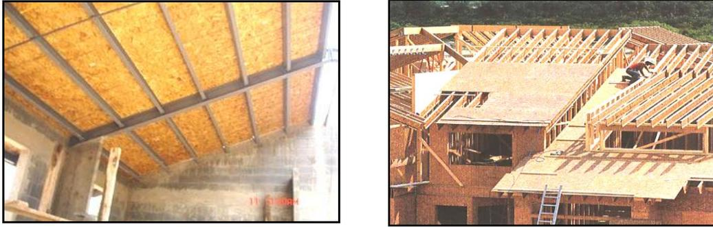
**Figura 5.** Tablero OSB en Techos.
