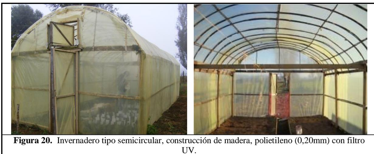
**Figura 20.** Invernadero tipo semicircular, construcción de madera, polietileno (0,20mm) con filtro UV.
