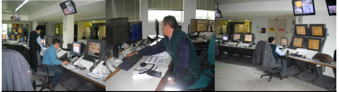
Fig 3. Puestos de Trabajo. Fotografías tomadas en la sala centralizada de la Planta CMPC celulosa santa fe.
