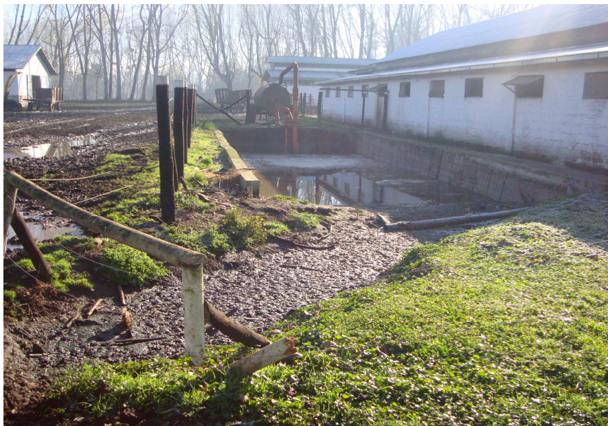
Anexo N° 12. Piscina purinera.
