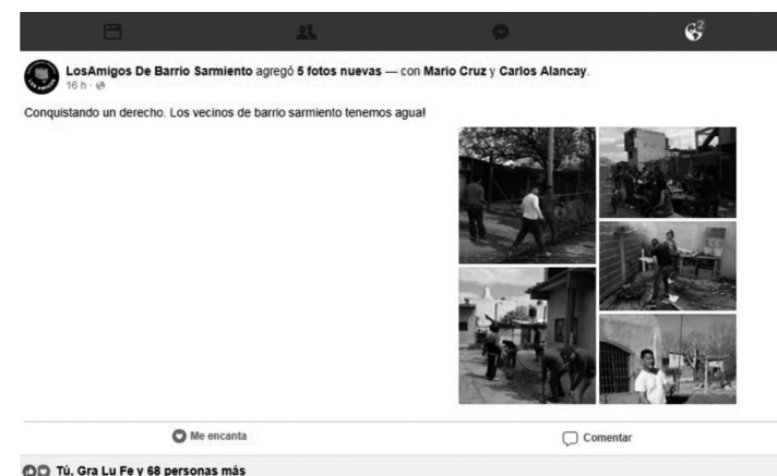
Imagen 1. Registro fotográfico de los vecinos de Barrio Sarmiento (Argentina) trabajando en la instalación de redes de agua. Publicado en redes sociales.
