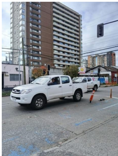
Figura 4.9: Degaste de demarcaciones, pintura y segregación de ciclovía San Martín.
