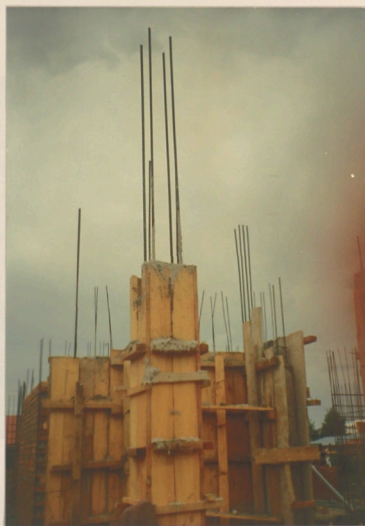
Se aprecia que los fierros sobresalen de los moldajes para su posterior traslape, al continuar hacia el segundo piso.
