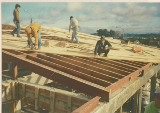
Se muestra la colocación de tijerales y encamisado sobre la estructura de acero
