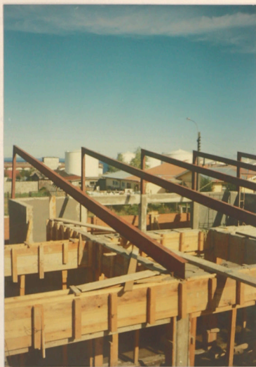
Instalación de los tijerales de acero
