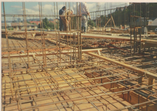
vista general de la doble malla de la losa
