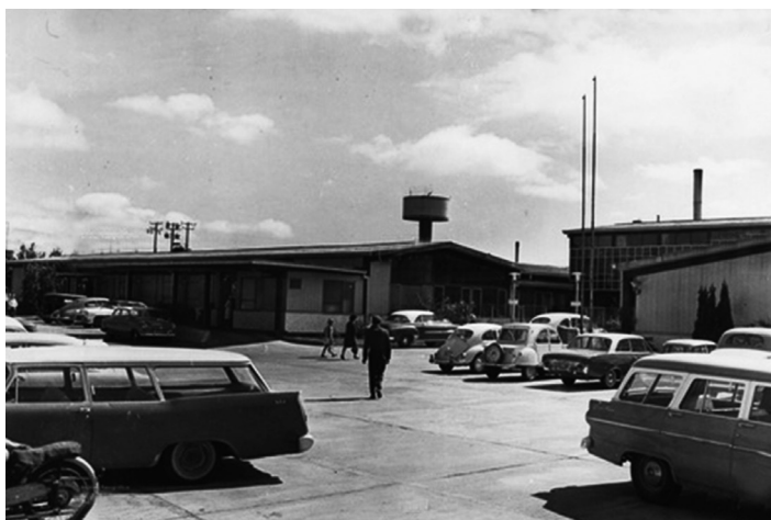
Imagen 5. Hospital de Emergencia John F. Kennedy, 1965
