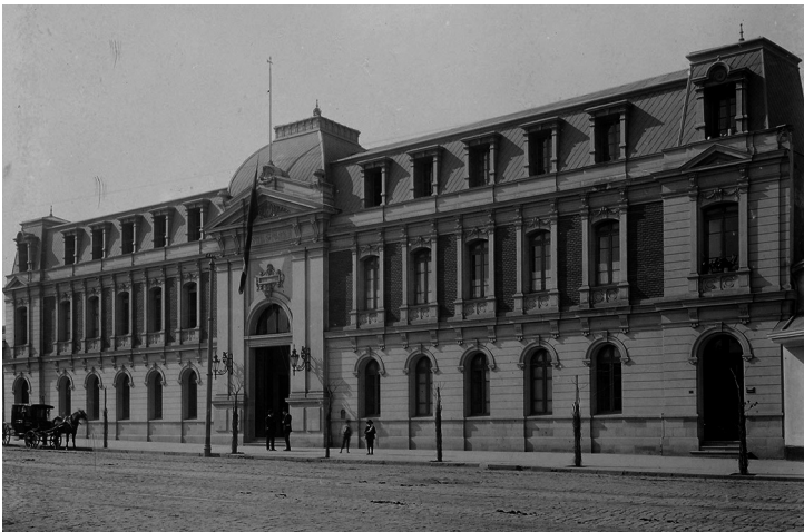
Imagen 2. Hospital San Borja
