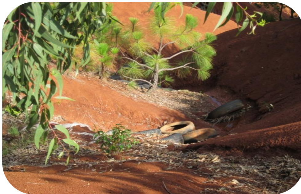
Figura 10 Cárcavas, áreas erosionadas de Atécuaro contenidas por neumáticos y sacos.
